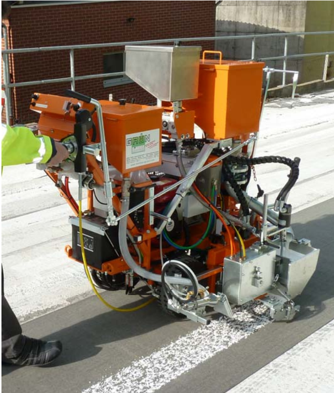
Abbildungen zeigen Durozet – 200 mit Ausrüstung für Strukturmarkierungen
