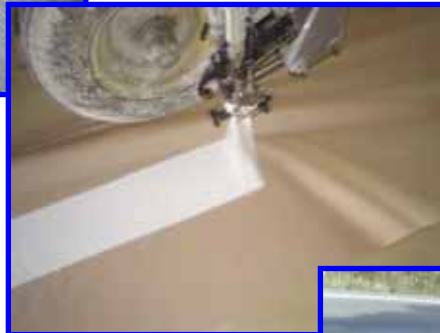
Außenmischung der beiden Komponenten „nass in nass“
